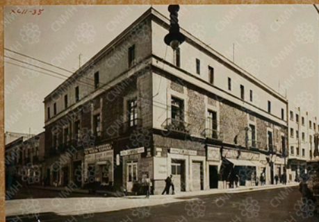
Mesones 4a. No. 87 y Cinco de Febrero No. 46. Fachada sin el aplando.
